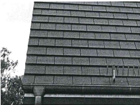
Abb. 20: Betonsteindach, Flachdachpfanne
