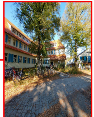
Umnutzung alter öffentlicher Gebäude
