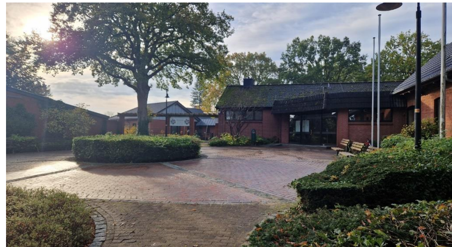
Abbildung 20: Gemeindezentrum in der Ortsmitte Kayhude (CIMA 2023)
