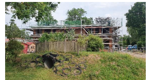
Abb.: Erweiterung der Kita
