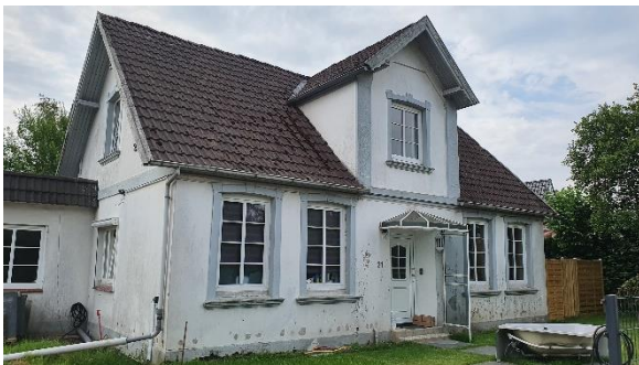
Abb.: Leerstand an der B 432, Quelle: inspektour 2021
