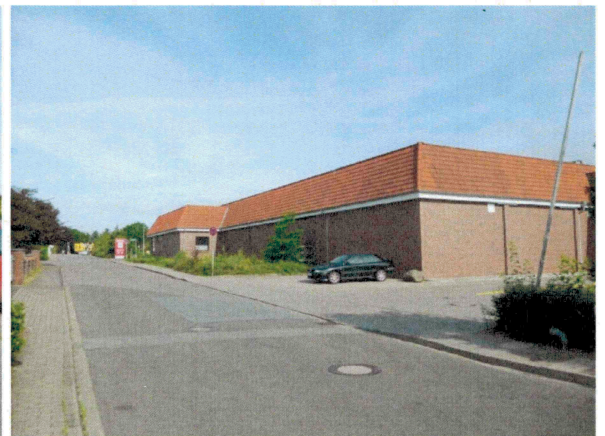
Abb. 7 Gebäudekante der Einzelhandelskomplexes zur Straße „Am Kronsmoor“ mit seitlicher Warenanlieferung (R. Pollok 18.06.2014)
