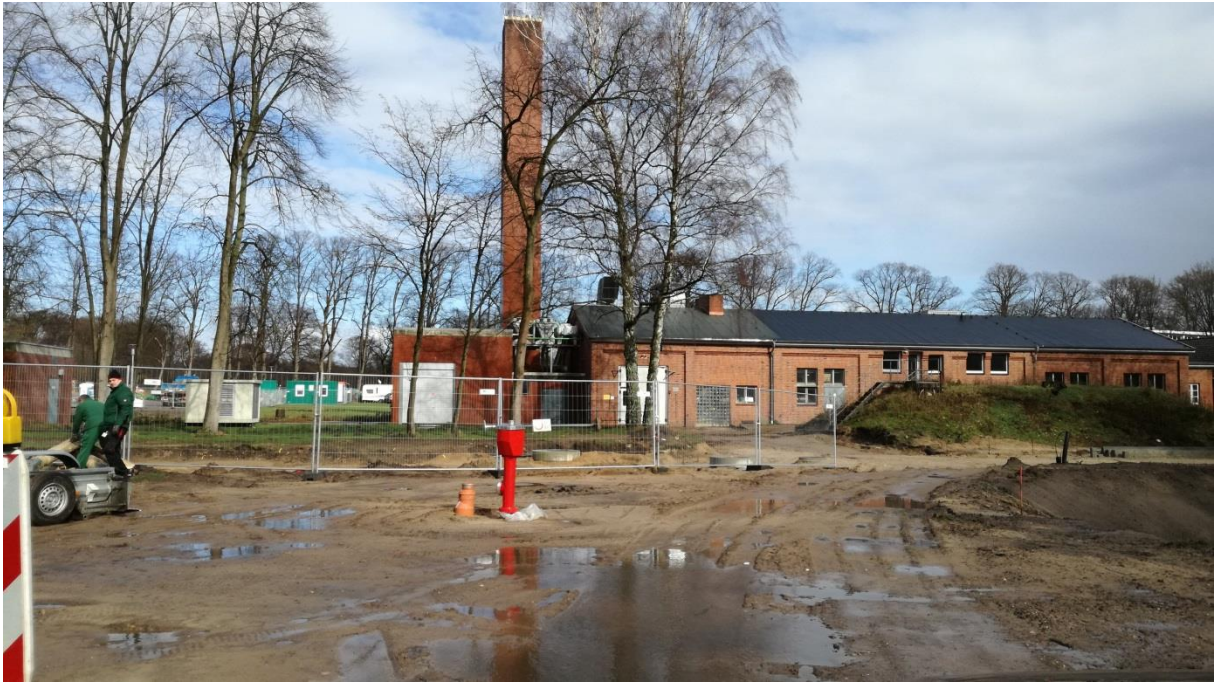
Baustellenbereich und Klinkerbauten (außerhalb Geltungsbereich)
