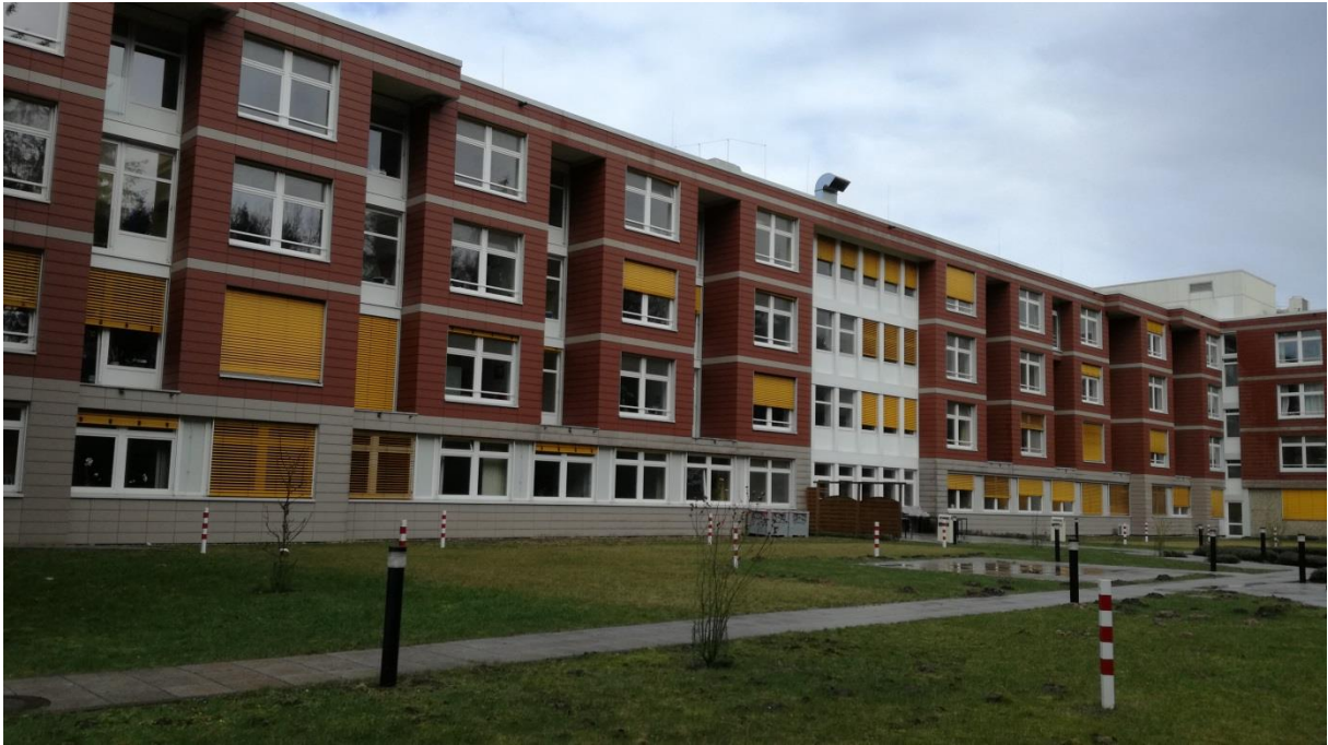
Klinikgebäude (Hauptgebäude) mit Bauweise ohne höhere Bedeutung für Vögel oder Fledermäuse
