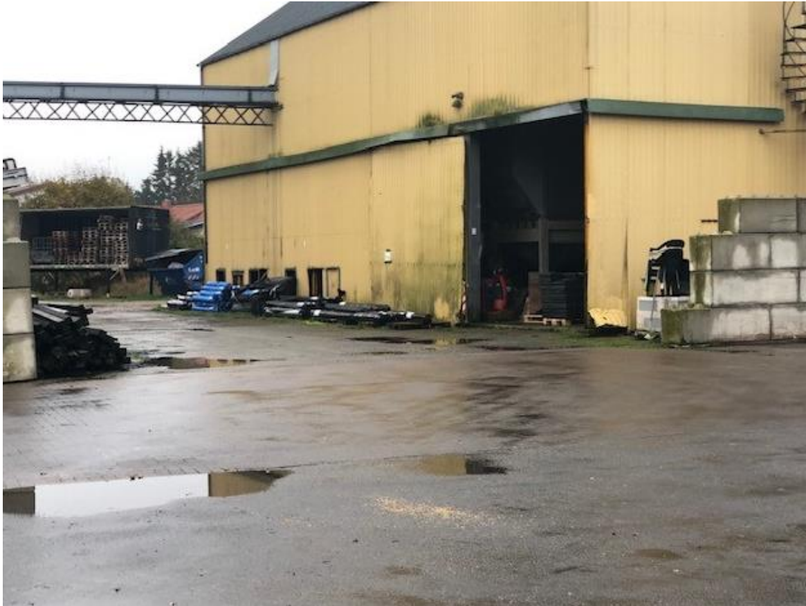
Abb. 7: Lagerhalle, Ersatzbau geplant
