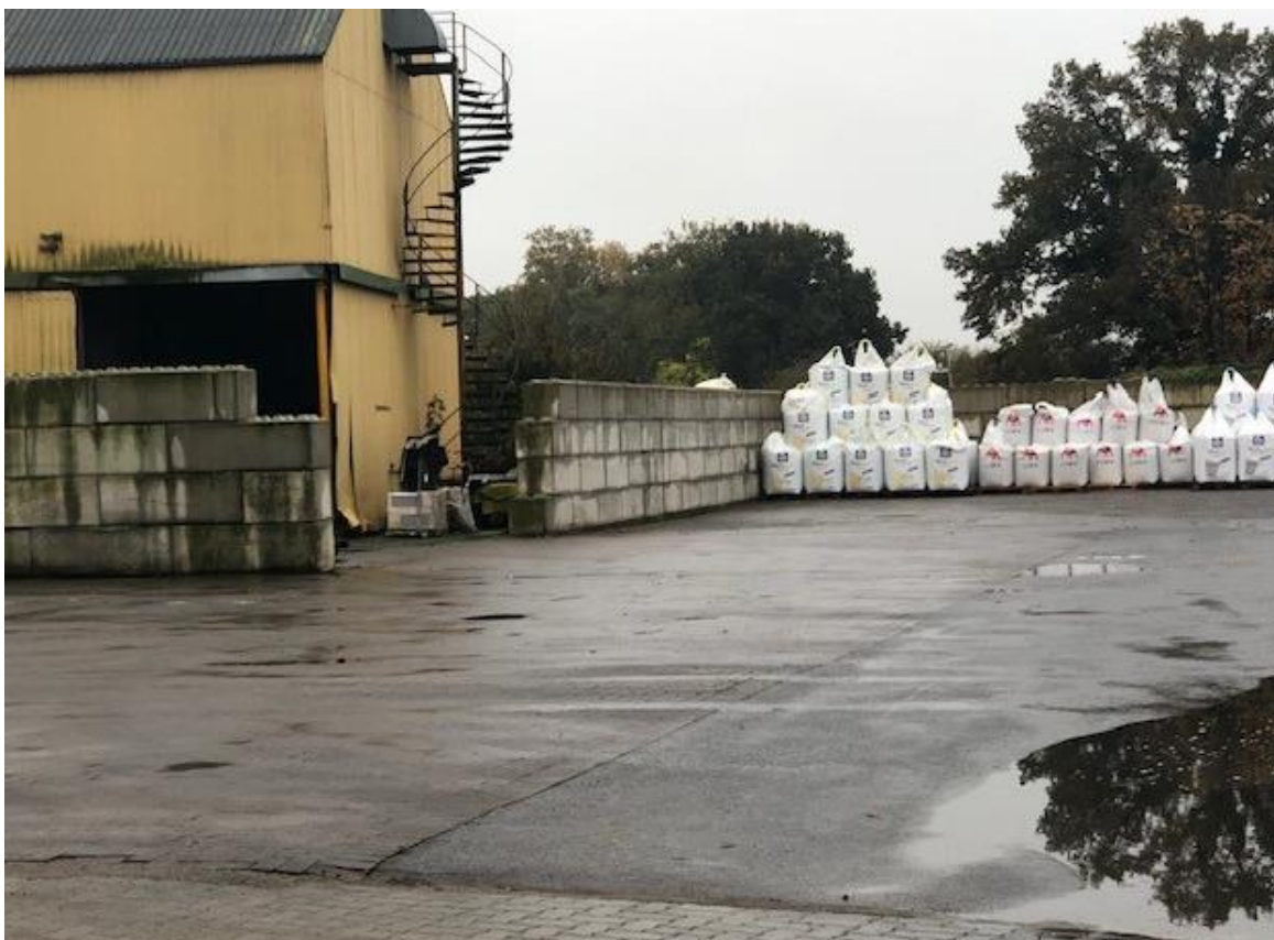
Abb. 8: Lagerhalle, Ersatzbau geplant
