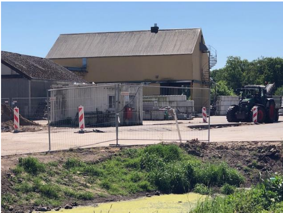
Abb. 6: Lagerhalle, Ersatzbau geplant
