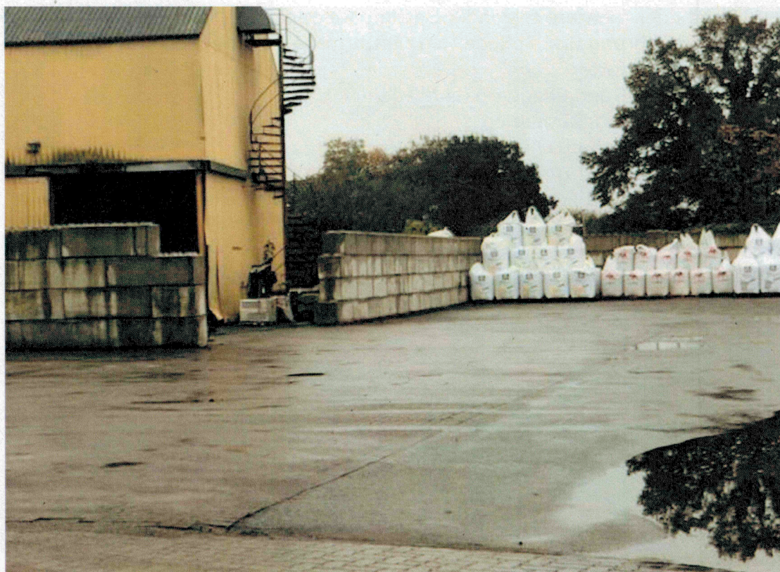
Abb. 8: Lagerhalle, Ersatzbau geplant
